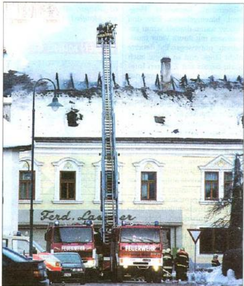
Zehn Wehren konnten am Sonntag mit 100 Mann ein Übergreifen der Flammen auf angrenzende Gebäude im Ortskern von Texing verhindern.
