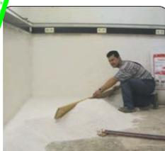
**Remblayer et régler:** Remblayer section par section. Placer une règle de nivellement à la hauteur de référence et planifier Thermo Floor de manière circulaire. La profondeur de pénétration peut être contrôlée par une inclinaison de la règle.
