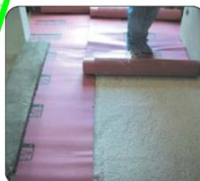
**Couvrir:** Couvrir Thermo Floor par un carton ondulé afin de protéger la Perlite et de retenir l'humidité du ciment.
