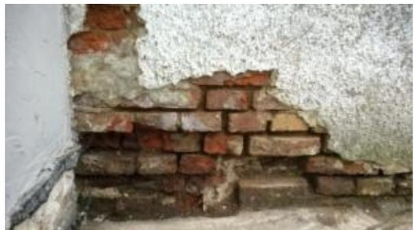
Frostsprennung Putz, Mauerwerk stark durchfeuchtet mit starker Versalzung
