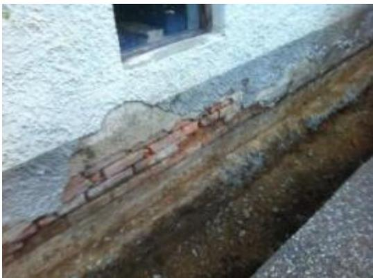
Frostsprennung Putz, Mauerwerk stark durchfeuchtet
