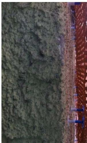
Der Vorteil einer zweischaligen Konstruktion liegt darin, dass bei dieser Konstruktion der Sockel vor Witterungseinflüssen geschützt ist und die Trocknung der Wand im Sockelbereich weitgehend unabhängig von Witterung stattfinden kann. Dies gilt vor allem für Sockelbereiche die einen sehr starken Versalzungsgrad aufweisen. Ein weiterer Vorteil ist, dass die kalte Außenluft und Wind nicht mit der ursprünglichen Wand entlang streichen kann und somit die Auskühlung vermindert wird.
