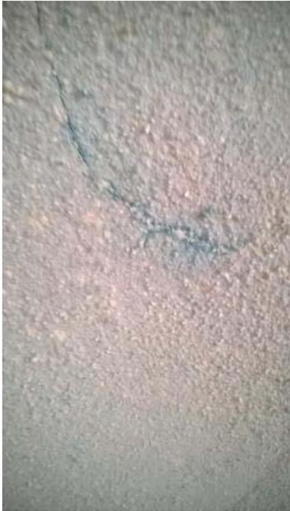
Durch die Verfärbung kann in etwa der Versalzungsgrad bestimmt werden.
