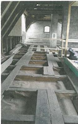
Thermo-Baupapier als Windbruch und Rieselschutz
