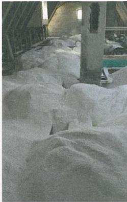
Einblasen, mit einer Latte verteilen, verdichten → FERTIG!
