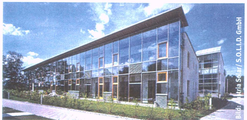
Das Bild zeigt ein Mehrfamilienhaus in Gneis Moos, 410 m<sup>2</sup> Kollektor, 100 m<sup>3</sup> Pufferspeicher, Warmwasser und Heizung, Ertrag 377 kWh/m<sup>2</sup> und 32% Jahresdeckungsgrad, 61 Wohnungen, errichtet 1999.
