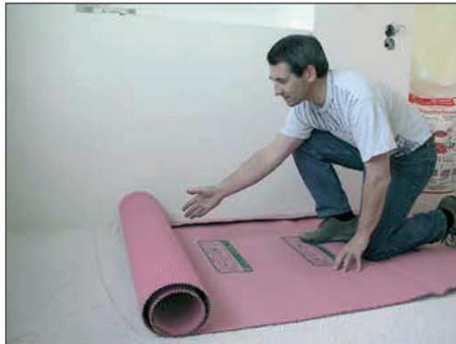
Thermo-Rollpappe wird auf die Thermo-Floor®-Schicht verlegt.
