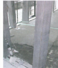
Trennlage und Estrich
