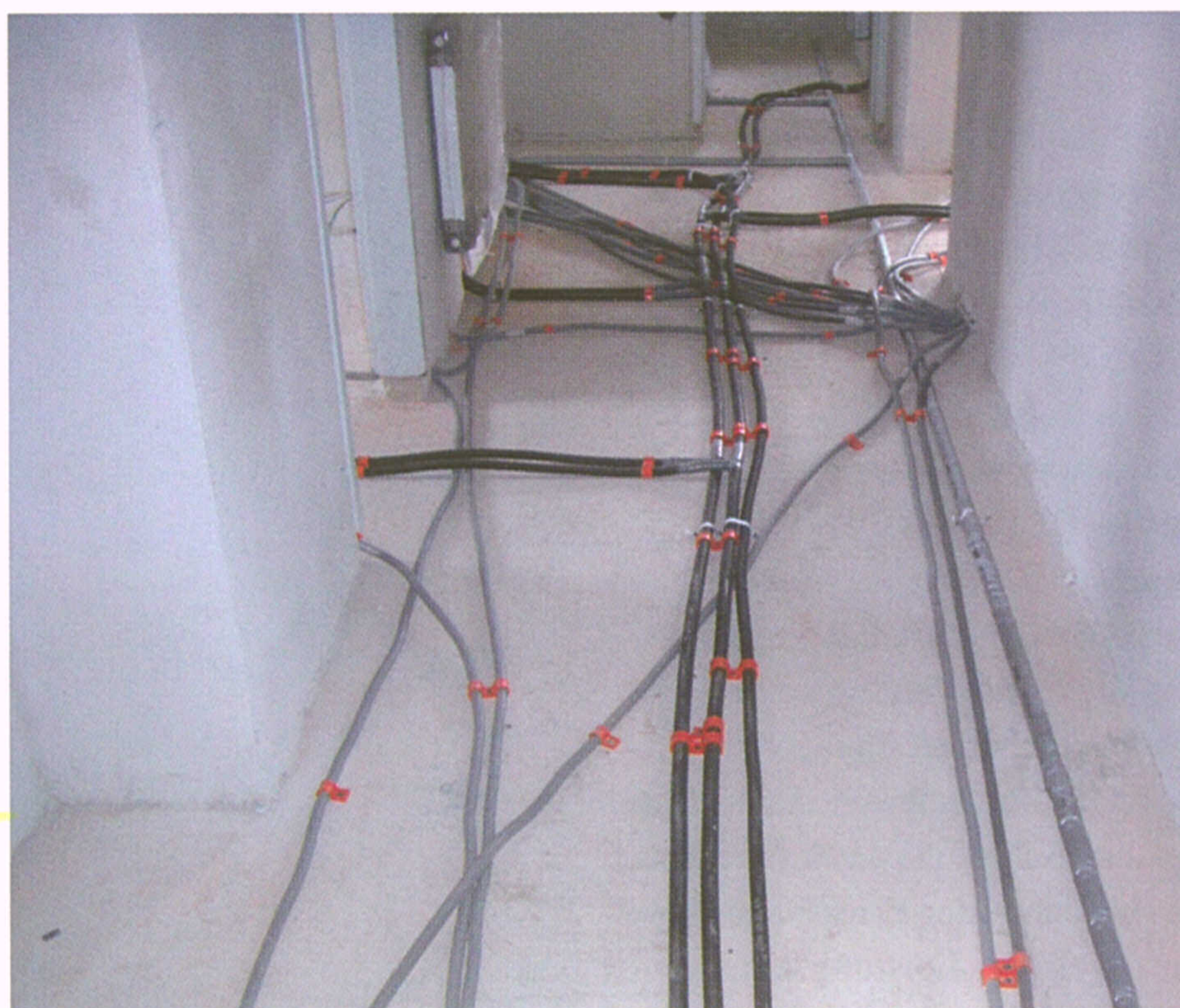
Die Schallschutzproblematik ist eine Herausforderung für jeden Estrichleger. Durch Rohrleitungen und Bodenkanäle dürfen Schall- und Wärmedämmschichten nicht geschwächt werden. Diese Tatsache muss schon in der Planung berücksichtigt werden.
