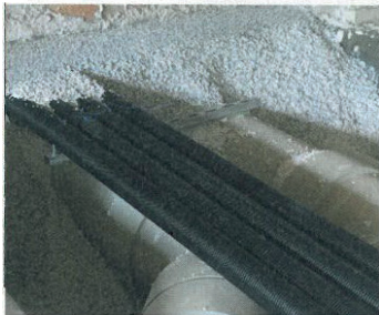
Dem Leitungswirrwarr begegnete man mit einer Dämmschüttung
