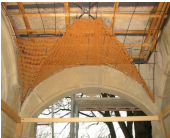
Sanieren auch auf feuchtem Grund
