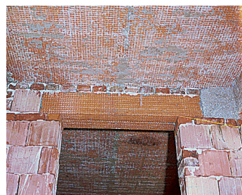
Verkleiden Stahlträger und Holzbalken
