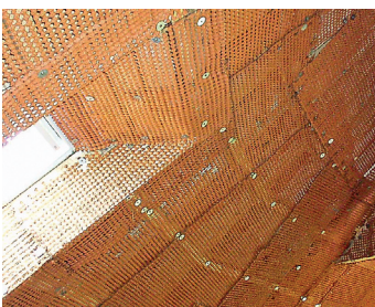
Dachgeschoss diffusionsoffener Ausbau
